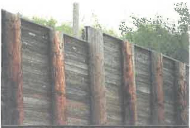
Wood barrier:tongue and groove planking
